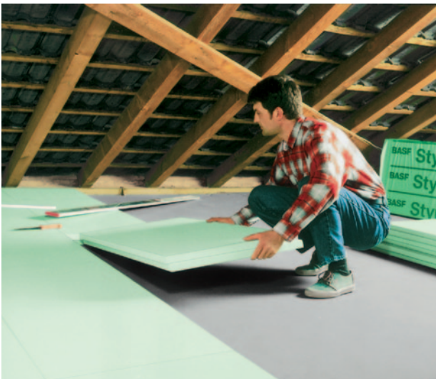
Abb. 4: Dämmung eines Dachraumes mit Styrodur® C.
