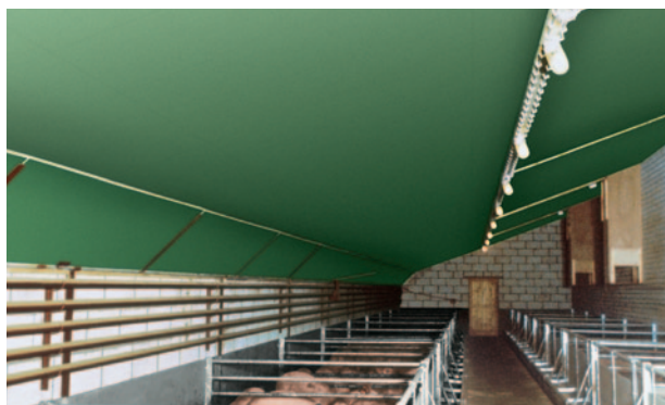
Abb. 3: Dämmung eines Stalls.
