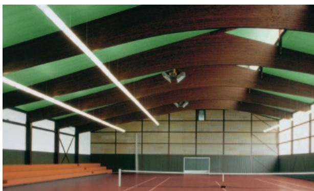
Abb. 1: Dämmung einer Sporthalle mit Styrodur® C.
