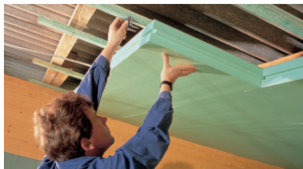
Abb. 7: Anbringung von Styrodur C-Platten.
